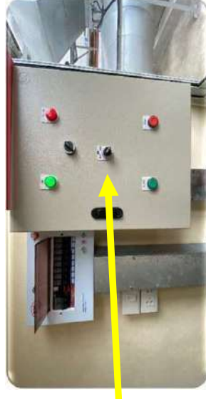
5. หมุนปิดสวิตช์ปั๊ม เชื้อเพลิง มาที่ตำแหน่ง Off
